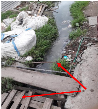
Foto 10. Conexión de agua no reglamentaria en contacto con el canal donde se arrojan los desechos cloacales y basura domiciliaria.
