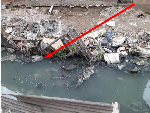
Foto 8. Conexión de agua no formal
